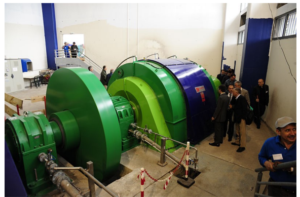
Alternateur de la centrale électrique ( imazpress.com)
